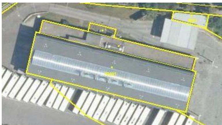
Hala povrchových úprav – 3
